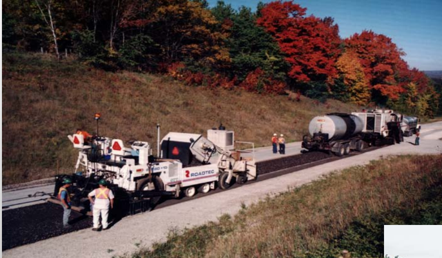
► Cold In-Place Recycling (CIR)
