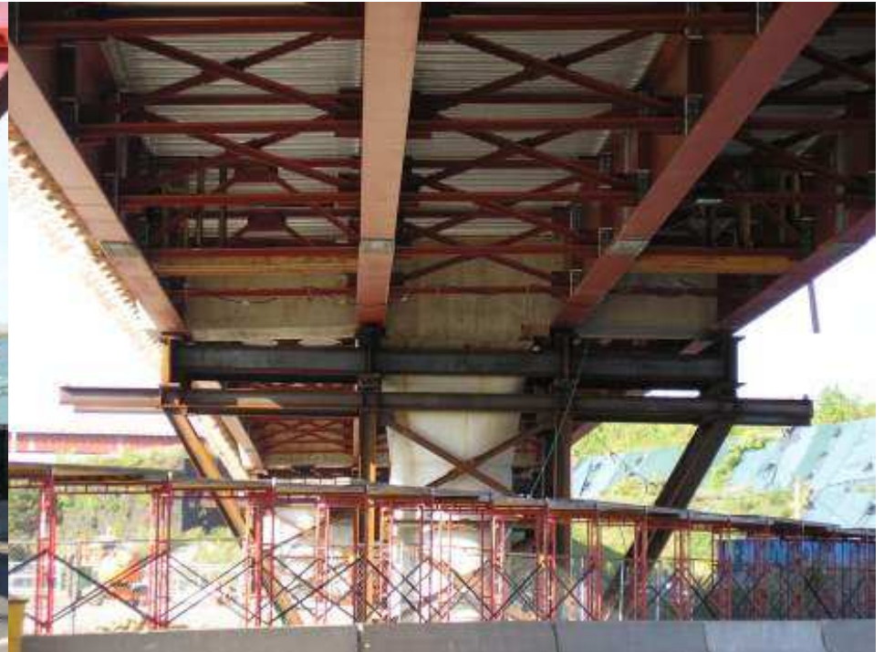
After concrete pour
