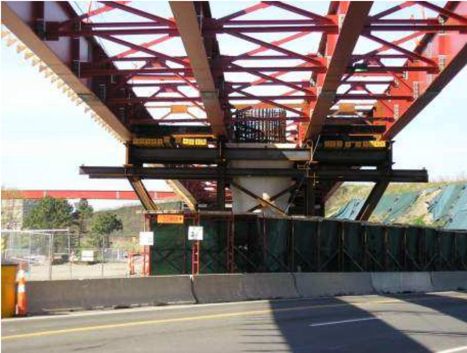
Before concrete pour
